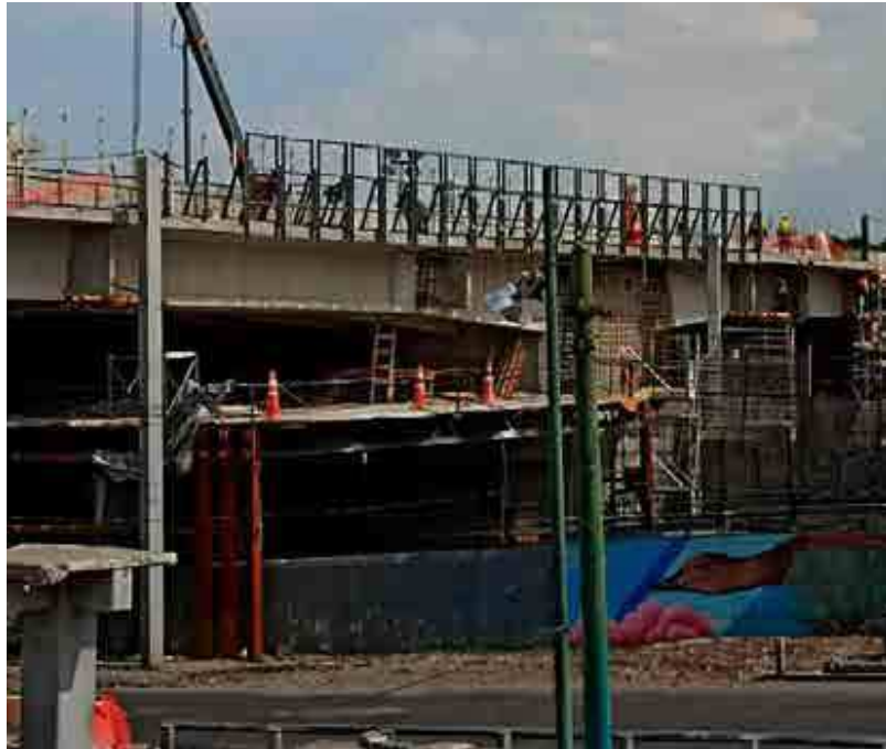
Obras de renovación de Línea 9 del Metro
