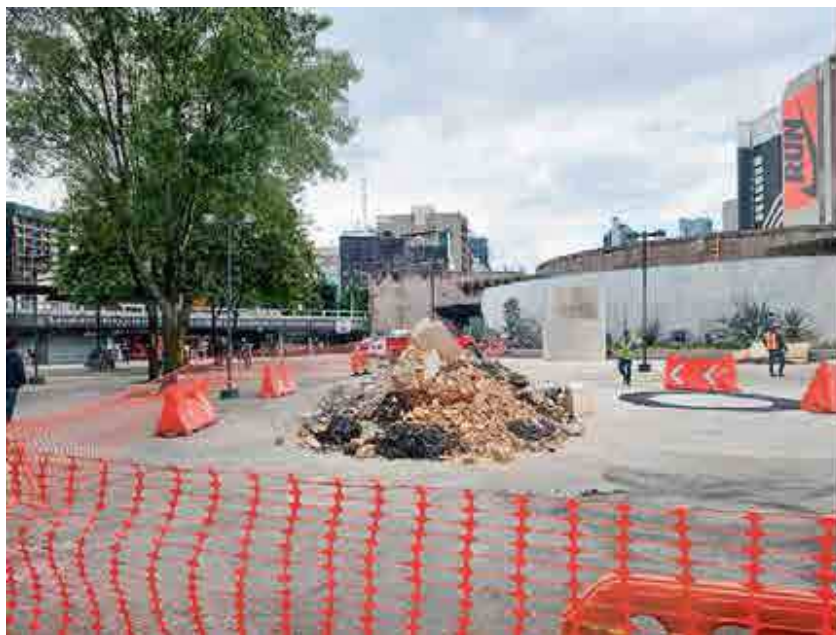
MISIÓN. Trabajadores de la obra, laboran sin parar para tener lista la Glorieta de Insurgentes antes del próximo viernes 4 de octubre.
