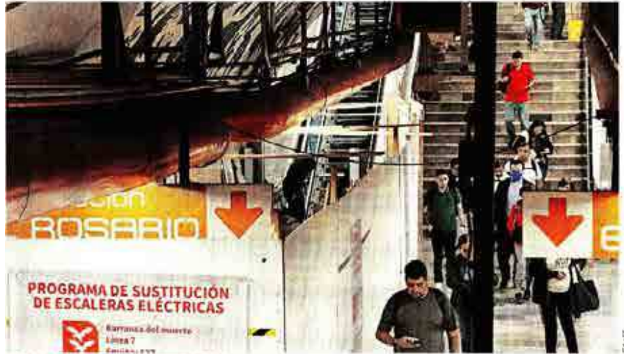
COMO SI FUERAN ETERNAS. Las obras de sustitución de escaleras se han extendido por más de dos meses en cinco estaciones de tres líneas distintas.
