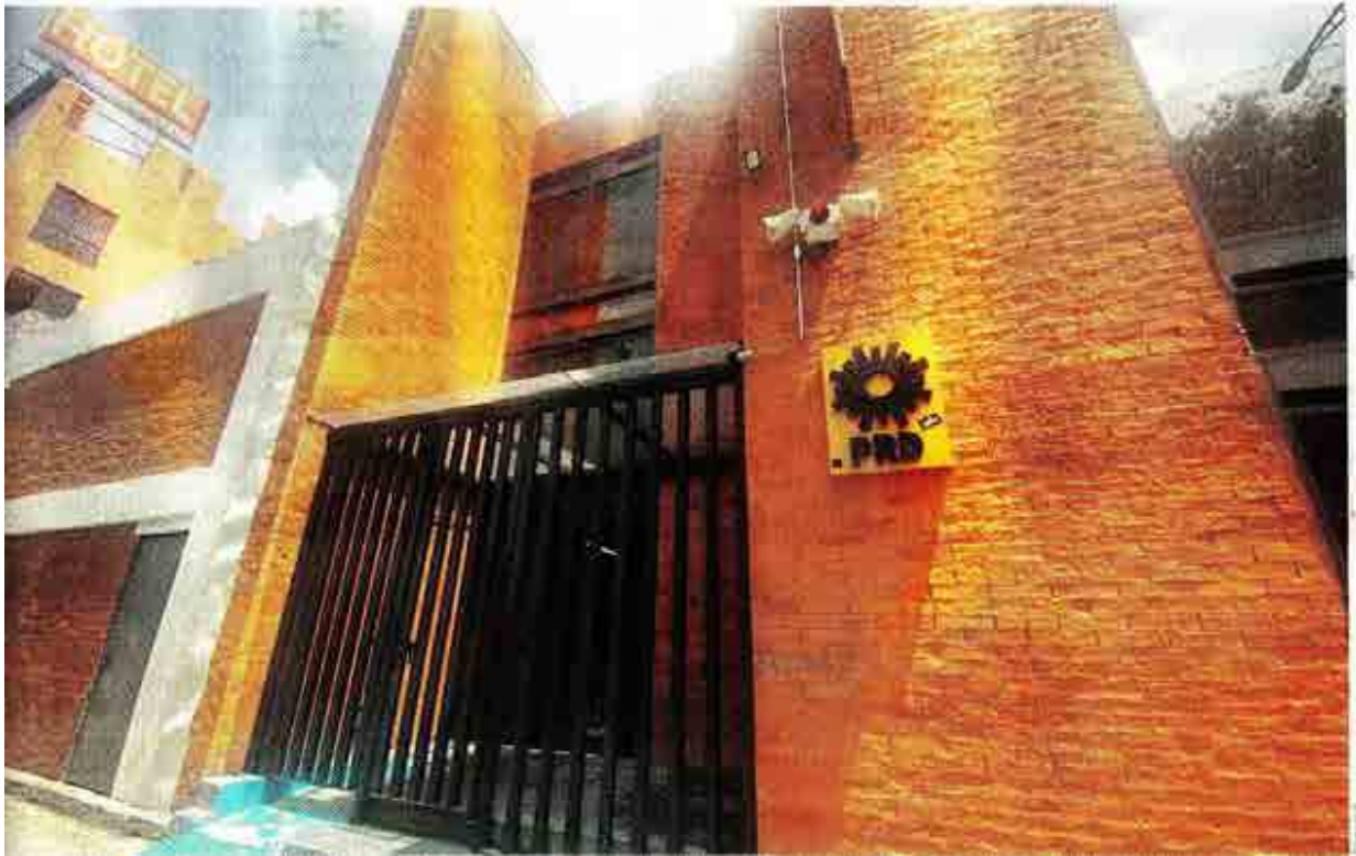
■ El inmueble que disputan los perredistas está en la Avenida Monterrey, en una de las zonas de mayor plusvalía de la Ciudad de México.
