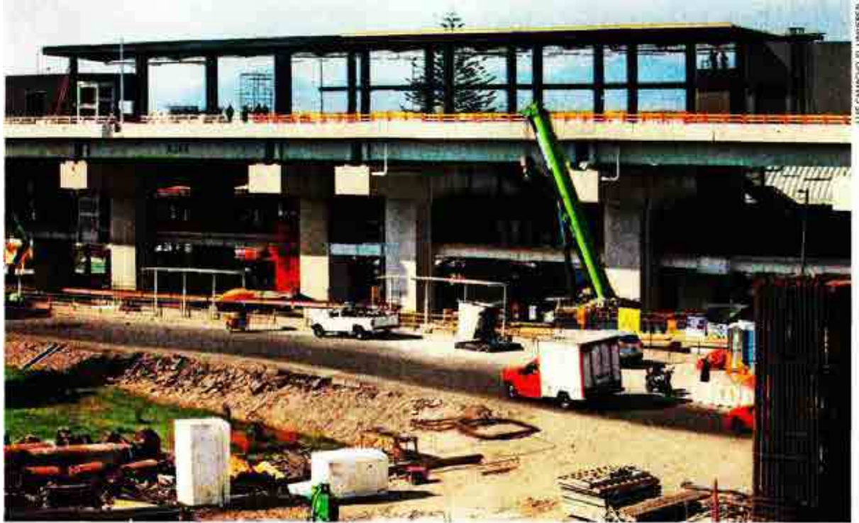
Avanzan en trabajos de construcción del Trolebús en el paradero de Santa Martha, el cual conecta a Constitución de 1917.
