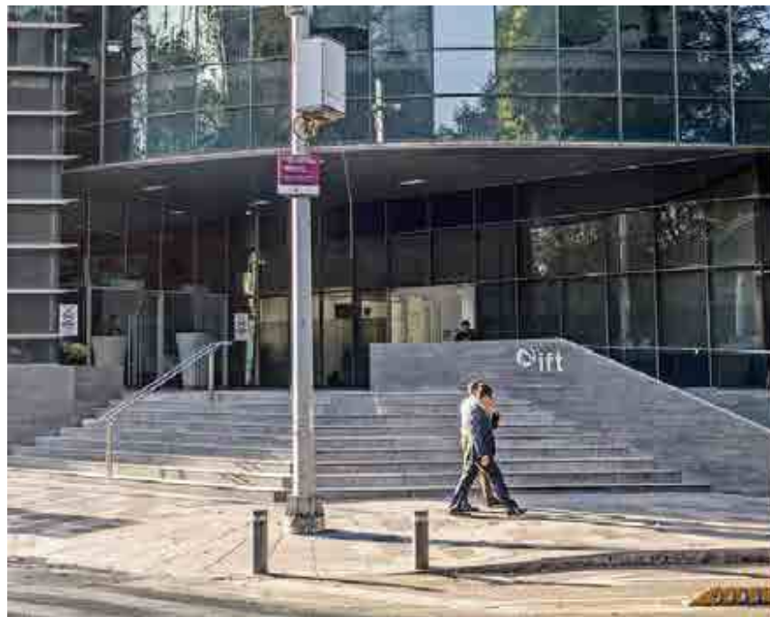
INMUEBLES. Tan solo los edificios del Instituto Federal de Telecomunicaciones (IFT) tienen un valor de 970 millones de pesos.
