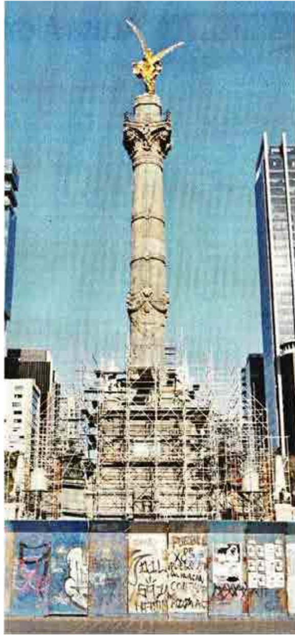
RESCATE HISTÓRICO. El basamento de la columna del Ángel de la Independencia es sometida a labores de limpieza y restauración.
