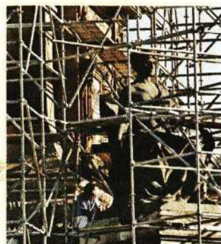
■ Un andamio fue ubicado alrededor de la estructura construida a principios del siglo 20.
