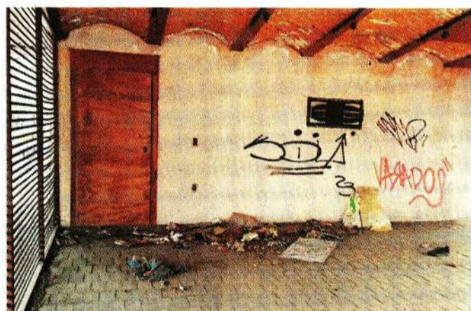
■ Un foro metálico quedó sin uso.
