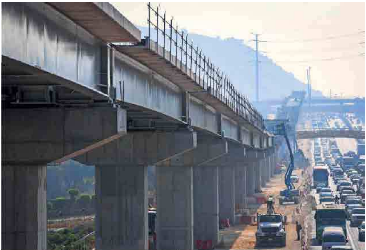
En el tramo que está en el límite de la alcaldía capitalina Iztapalapa y el municipio mexiquense de Los Reyes La Paz aún no se ha concluido la colocación de las ballenas.
