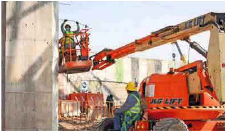
Sobre los carriles laterales de la autopista es donde hay mayor presencia de trabajadores y de maquinaria que participan en el proyecto.
