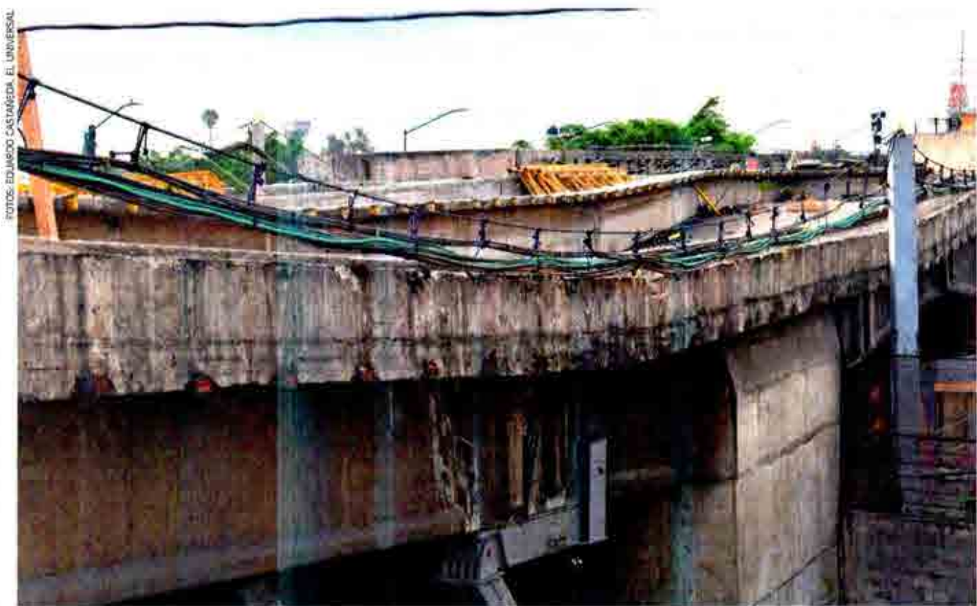
El Metro concluyó el retiro de vías, balasto y elementos electromecánicos del tramo a intervenir en la Línea 9.
