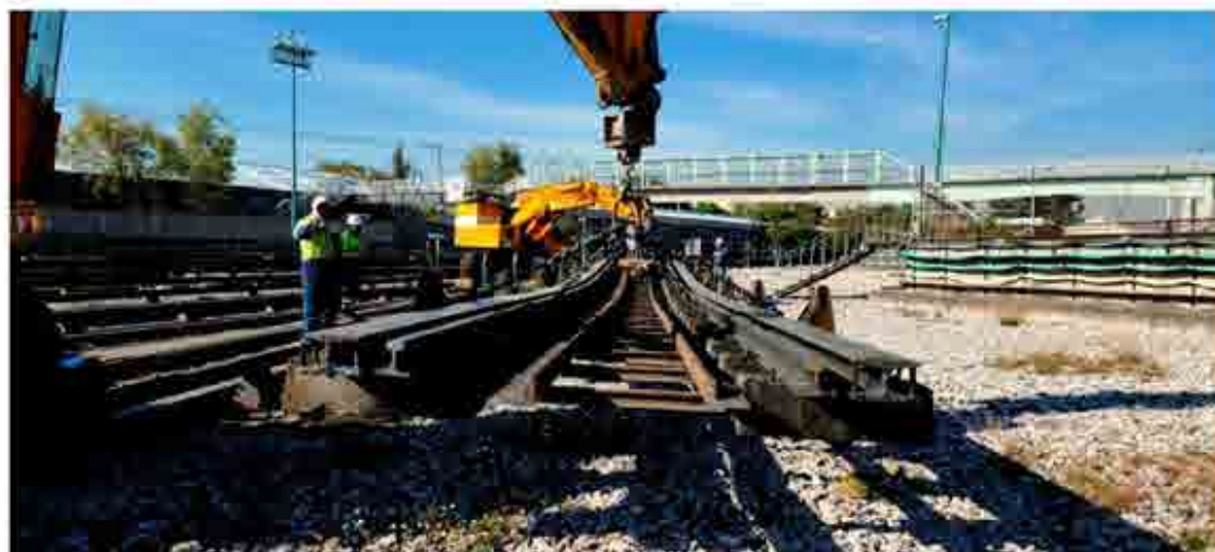
Desmantelamiento de vías en zona de Pantitlán.
