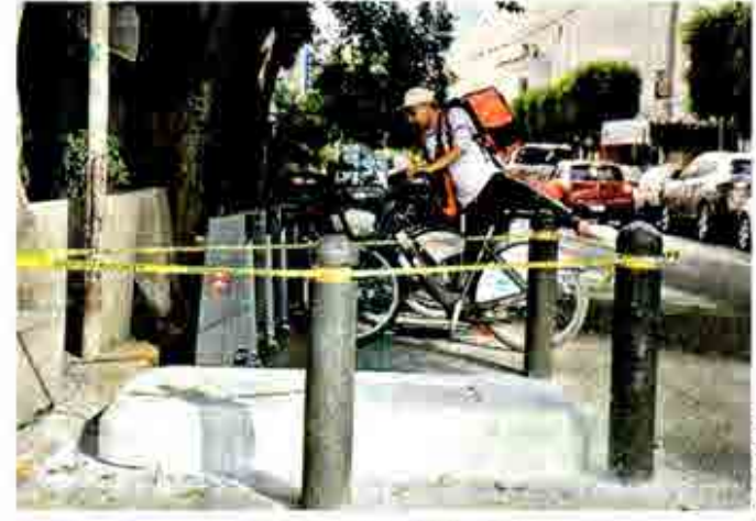
En estaciones de las colonias del Valle, Polanco, Nápoles y Doctores comenzó a ser construida la base.
