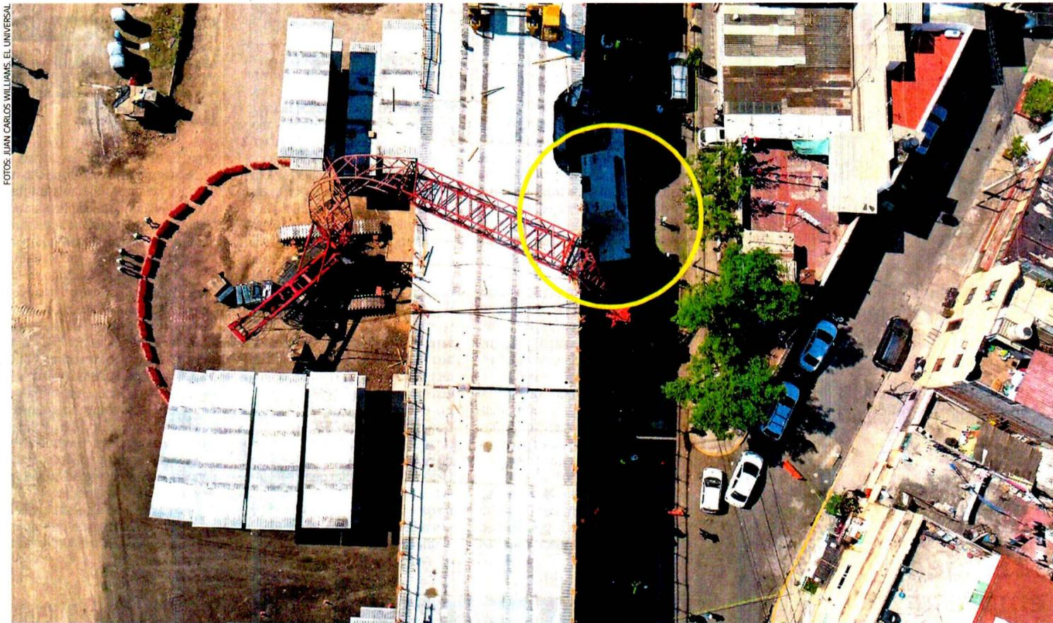
La estructura que se cayó era trasladada para ser montada en el apoyo 18. Se investiga si la falla se debió a un error en la operación o de la grúa.
