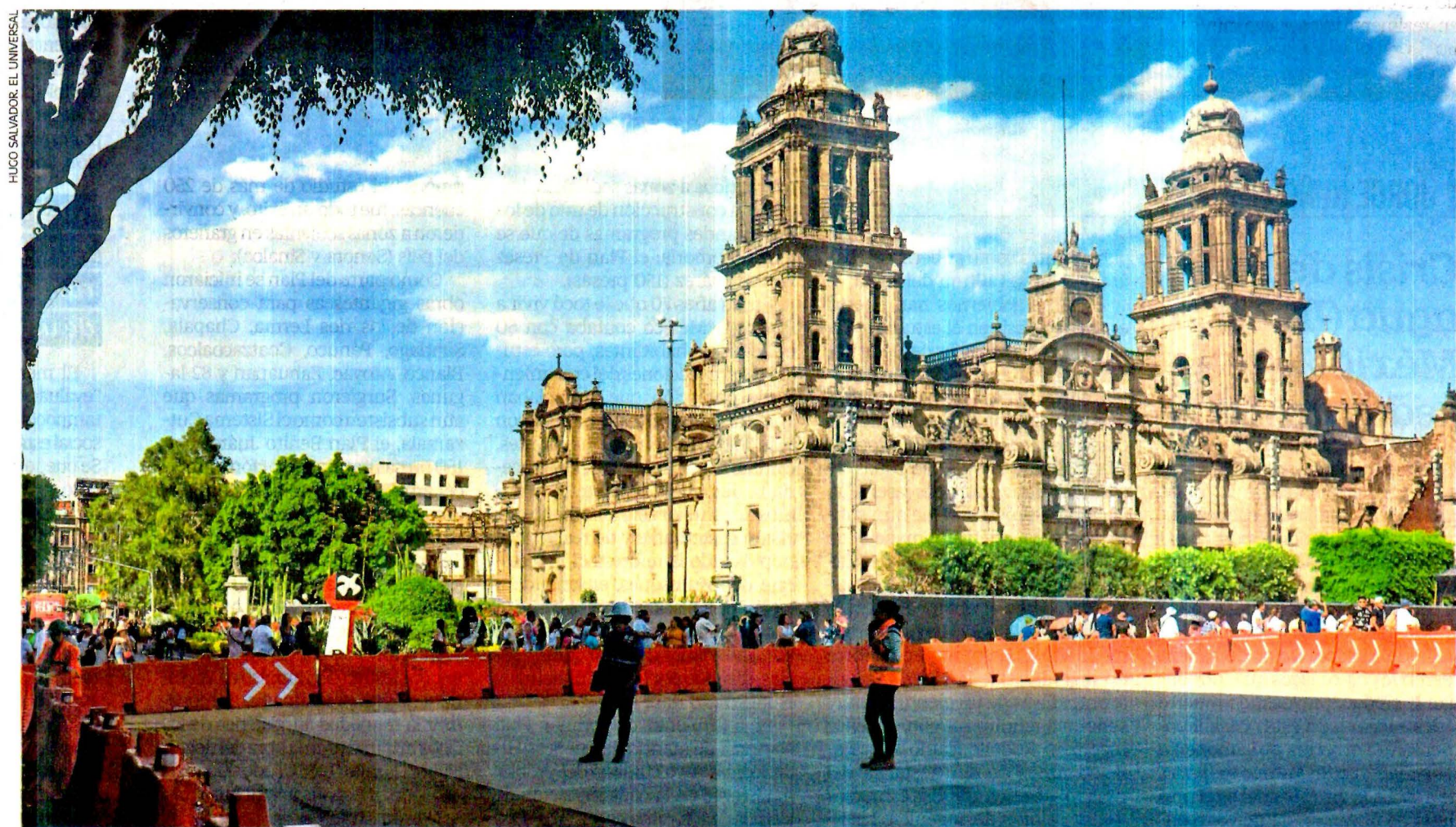
Para concluir las obras en tiempo, personal de la Sobse trabaja de forma permanente las 24 horas y confina la zona todos los días para realizar su labor.
