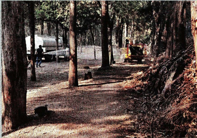
Los trabajadores señalaron que el suministro de agua ha disminuido.
