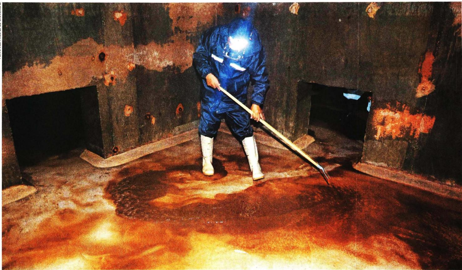
Para lavar la cisterna, el trabajador utilizó un detergente biodegradable para descomponer las grasas acumuladas y 8% de hipoclorito de sodio para potabilizar el agua.
