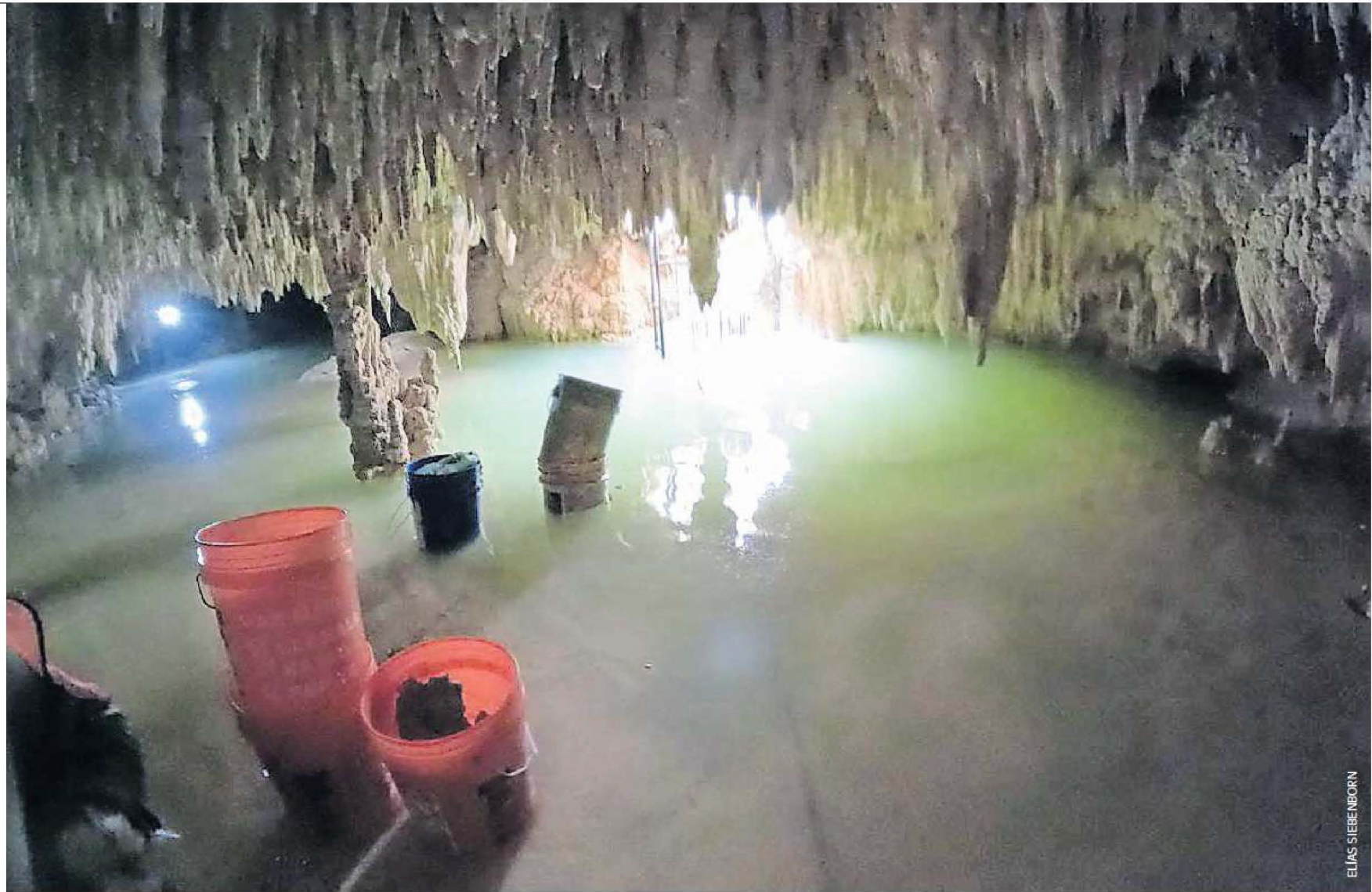
En el informe se detalla que al colocar los pilotes hubo afectaciones en las cavernas sobre las que corre el Tramo 5 Sur, como la caída de cemento en el agua.
