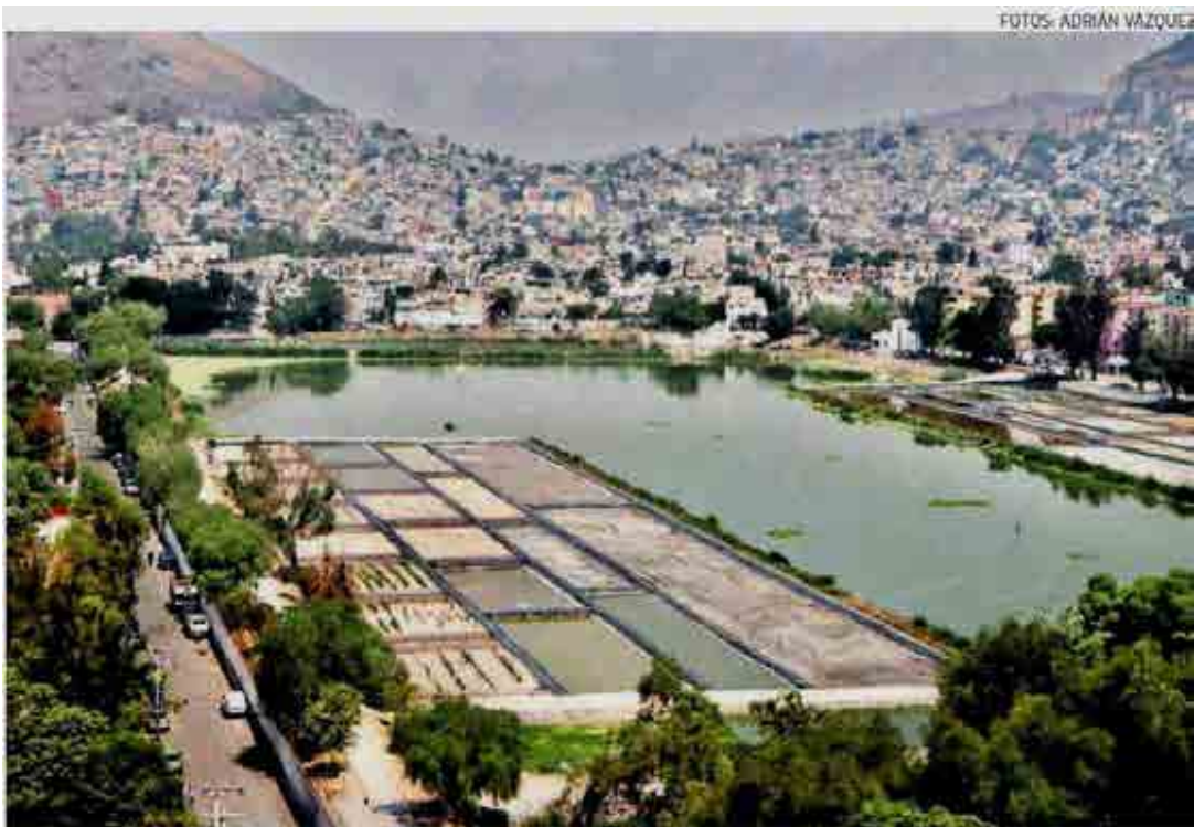
Desde el Cablebús se puede apreciar el avance de este proyecto
