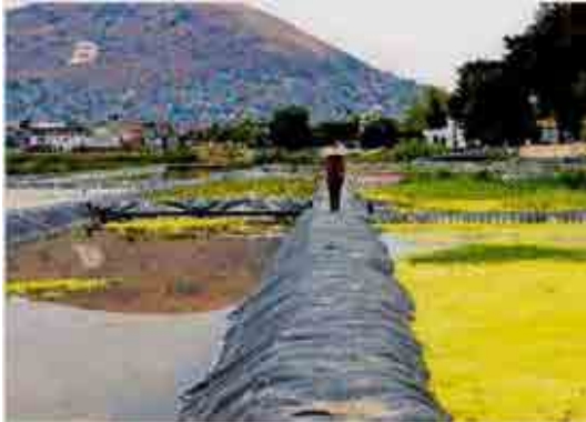
Esta es la zona donde se trata el agua
