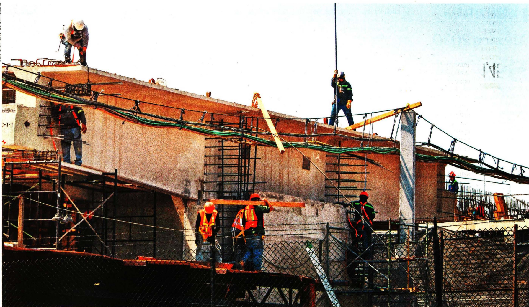
Trabajadores de la Secretaría de Obras reconstruyen el tramo elevado hacia Pantitlán, para evitar el desnivel registrado en esta parte.
