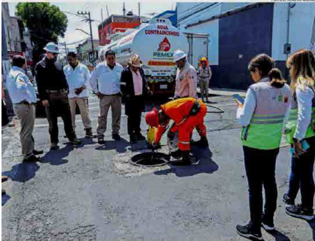
Personal de Pemex limpia las coladeras
