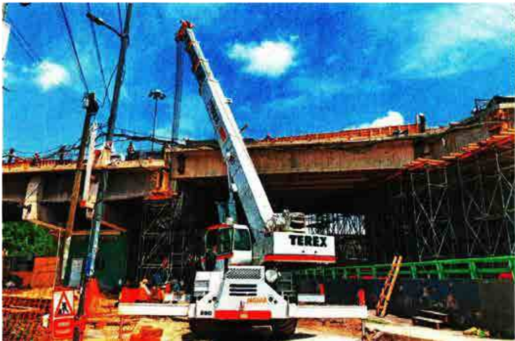
El tramo elevado de Pantitlán a Velódromo fue cerrado en diciembre pasado, para llevar a cabo obras de nivelación de vías ante el hundimiento de la zona.
