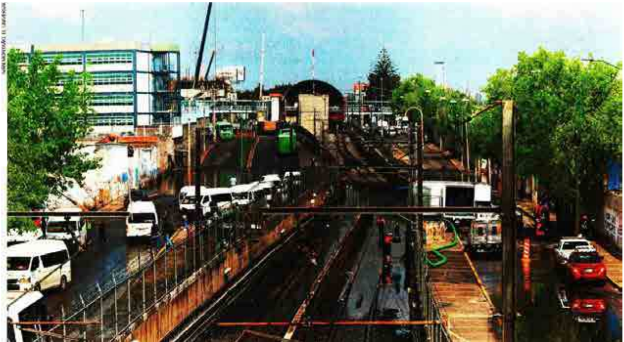
El agua de lluvia se estancó en el cajón de vías del tramo La Paz-Los Reyes, en la Línea A del Metro, por lo que personal del Sistema de Transporte Colectivo trabajó en el retiro del líquido y limpieza de la estructura para reanudar el servicio.
