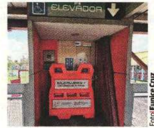
UNO de los elevadores, en la Línea B. Foto: Eunice Cruz
