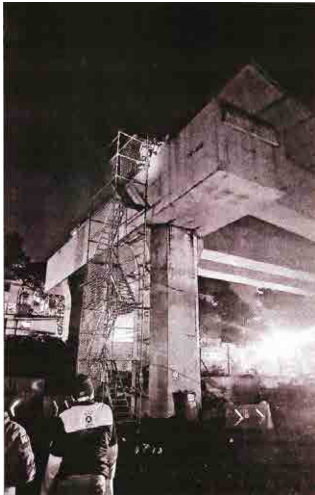
▲ Frente de obra de la calzada Minas de Arena, colonia Ampliación Acueducto, lugar del incidente y donde se hacían trabajos de soldadura, según la Secretaría de Obras y Servicios capitalina. Foto La Jornada
