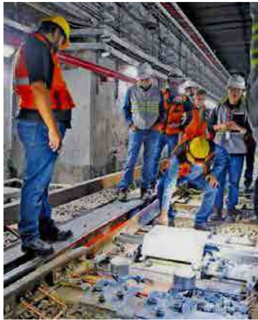
Dentro del Programa de Recuperación Operativa del Metro se desarrollan el mantenimiento de barras guía y equipamiento de talleres /CORTESÍA: STC METRO
