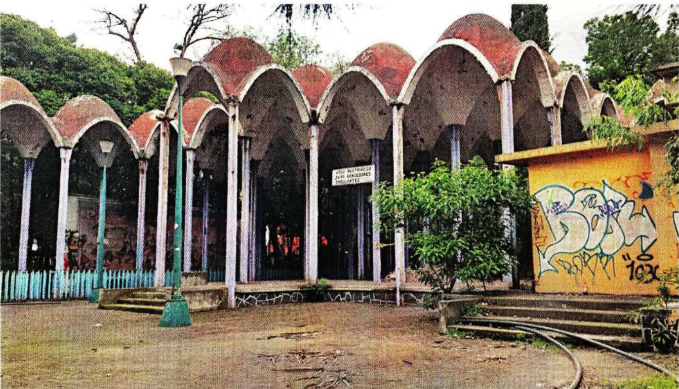
Diseñada por el arquitecto Leónides Guadarrama, la estación del tren permanece cerrada, pese al proyecto para recuperarla.
