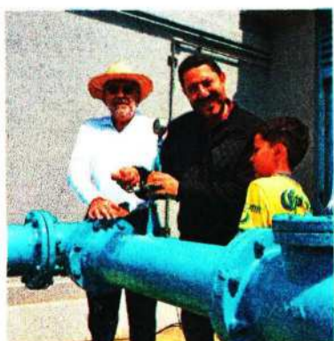
Batres dijo que el pozo S-9 estaba colapsado y por ello se rehabilitó.
