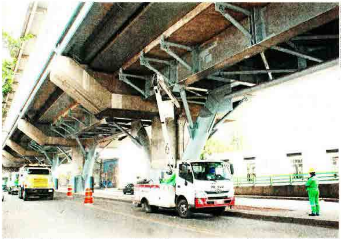
A más de medio año de su reapertura, el tramo elevado de la Línea Dorada opera con normalidad y con circulación continua de los trenes. Se espera que en noviembre finalice el proceso de revisión.
