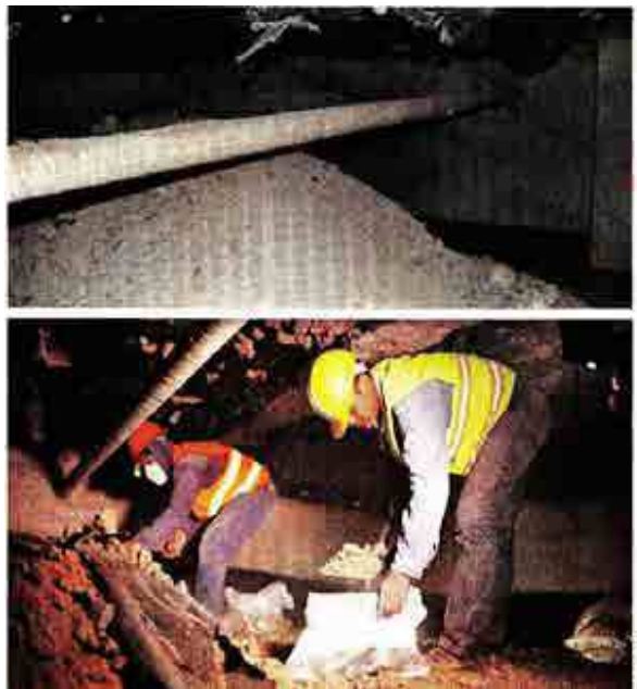
■ El Gobierno capitalino, bajo el cargo de Claudia Sheinbaum, se hizo cargo de la rehabilitación de la Terminal 2 en 2022.
