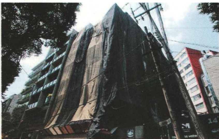
ESTE EDIFICIO en la calle de Chilpancingo sigue en reconstrucción.
