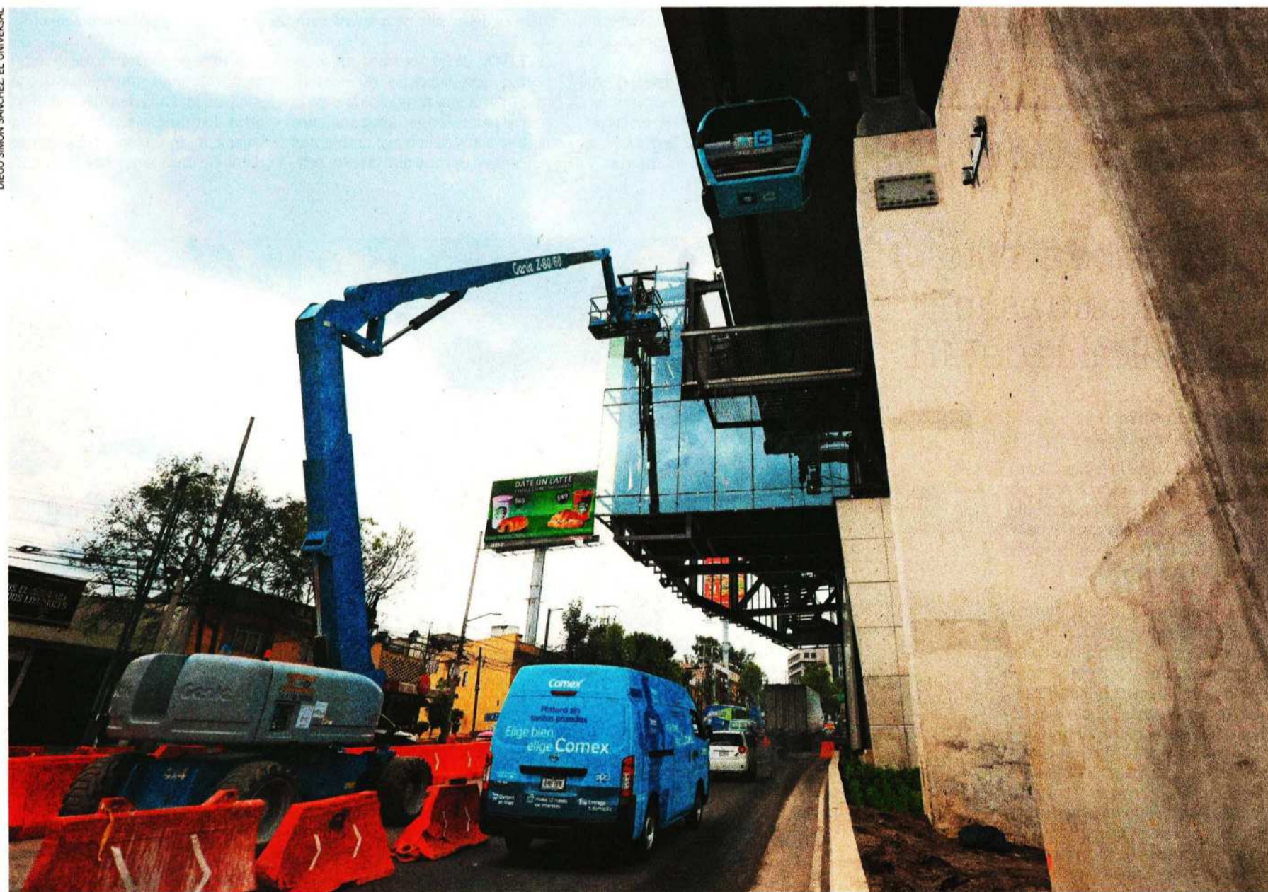
Trabajadores concluían obras en diversas estaciones de la L3 del Cablebús apoyados con maquinaria, lo que afectó la circulación vehicular sobre la avenida Constituyentes.
