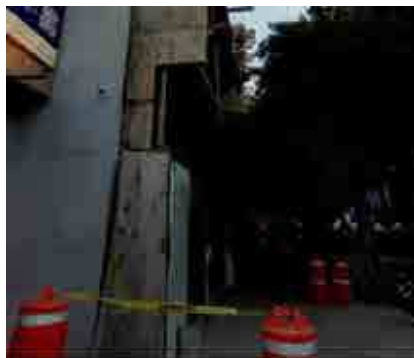
Foto: Especial / Riesgos en construcción BJ
