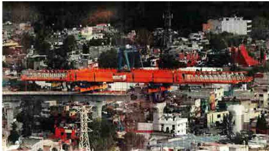
A TRABAJAR. Personal labora sobre las dovelas; las lanzadoras reanudaron el ensamblado.
