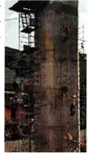
Las obras en columnas y dovelas se pueden apreciar en colonias como El Capulín.
