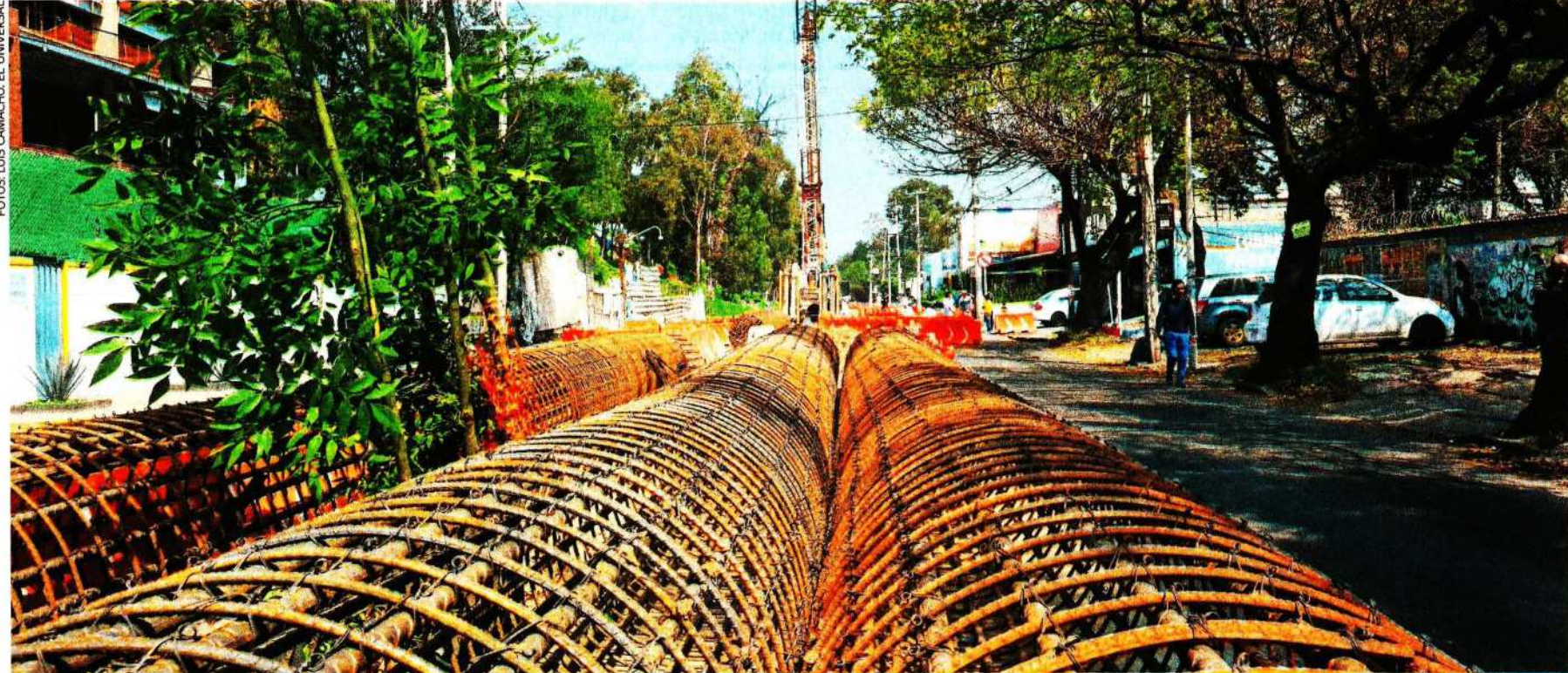
El Tramo 0 del Macrolibramiento Mexiquense va de Puente de Vigas hacia Periférico Norte, en el municipio de Naucalpan.
