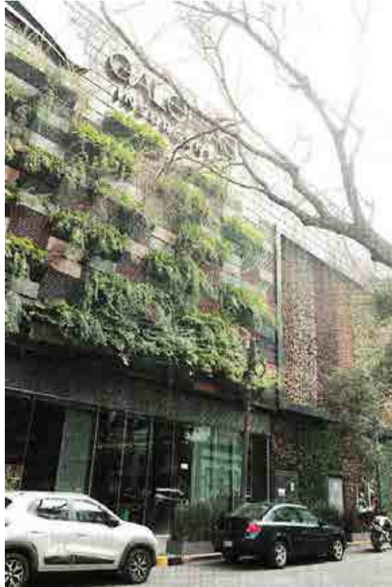
■ La explosión ocurrió en la esquina de Oso y Parroquia, en la Colonia del Valle.
