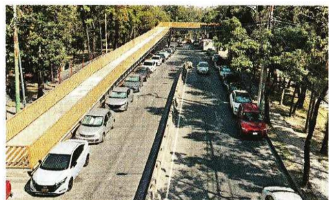
Vehículos son estacionados en los costados del puente en construcción.
