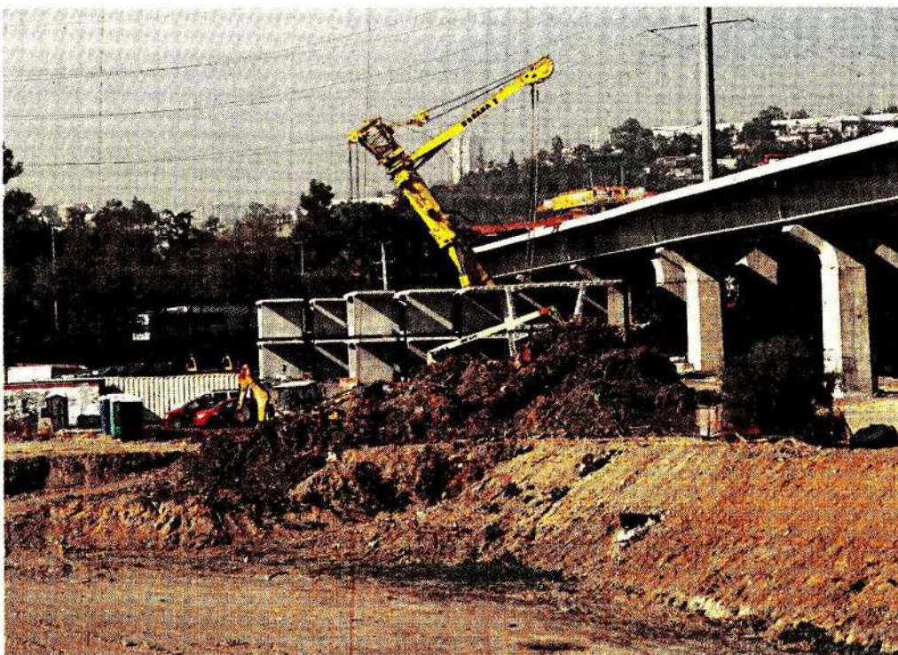
Maquinaria trabaja en las obras que conectarán la estación Santa Fe del Tren Interurbano con el Complejo Observatorio, en el que convergerán también las líneas 1 y 12 del Metro.
