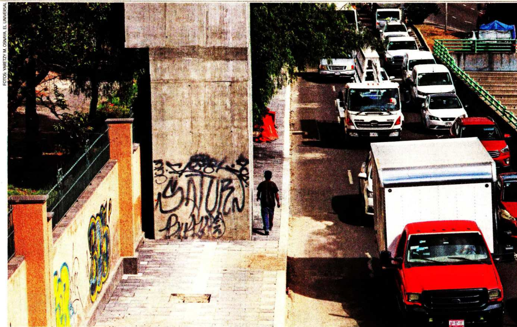
Las siete torres en forma de L que obstruían el paso peatonal cuando empezó la construcción ya tienen banquetas más amplias, de casi un metro de ancho.
