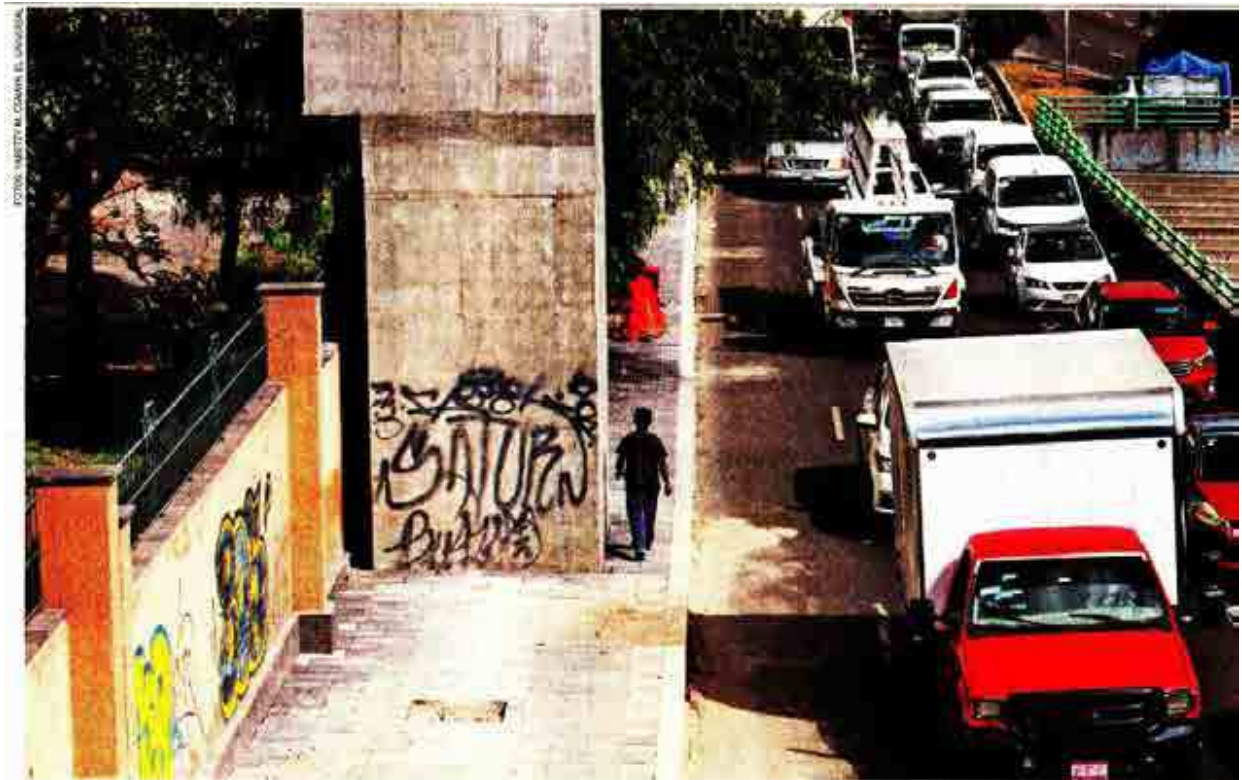
Las siete torres en forma de L que obstruían el paso peatonal cuando empezó la construcción ya tienen banquetas más amplias, de casi un metro de ancho.
