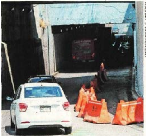
En el bajopuente, la ciclovía se encuentra confinada con trafitambos para proteger a los ciclistas de los autos.
