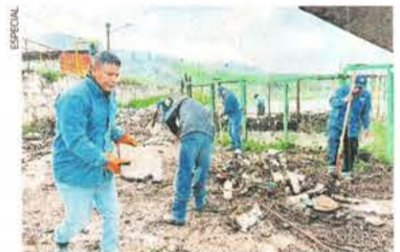
Los trabajos se realizaron en coordinación con autoridades municipales, estatales y federales.
