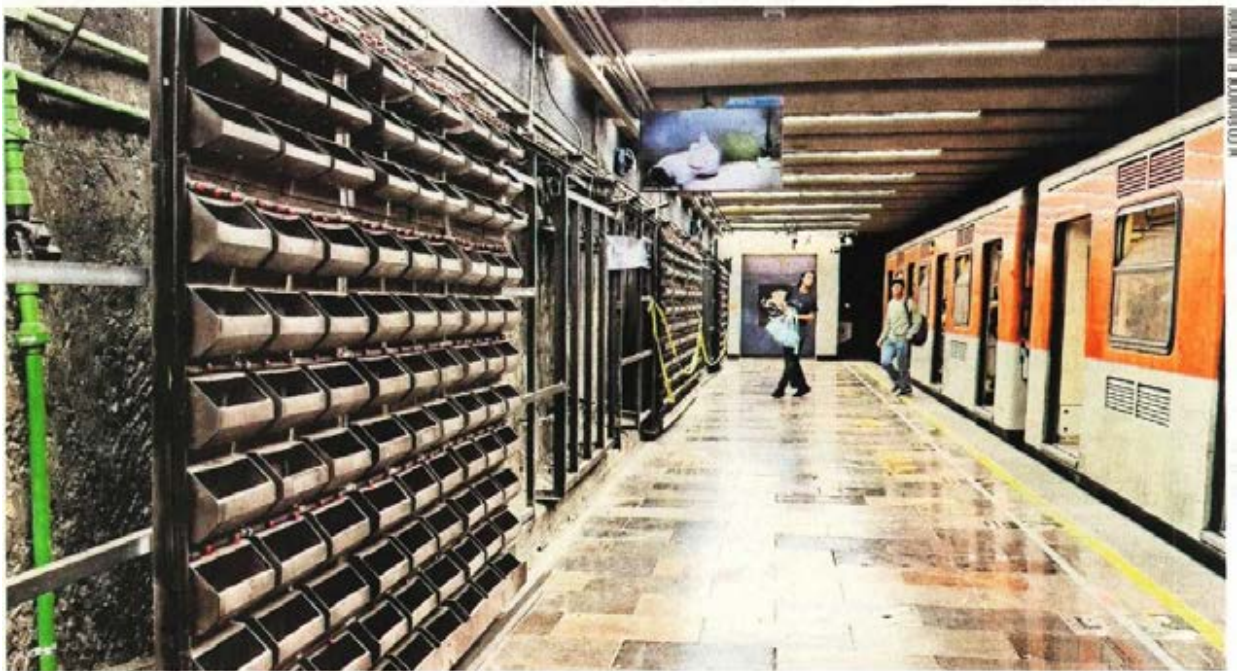
En Zócalo ya se instalaron las estructuras donde irán las plantas en diferentes puntos de los andenes; las macetas cuentan con tubos integrados para el sistema de riego.
