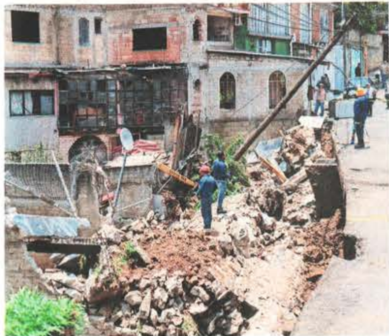
En la alcaldía Cuajimalpa, las viviendas de al menos 50 familias sufrieron afectaciones por la intensa lluvia del lunes por la noche.
