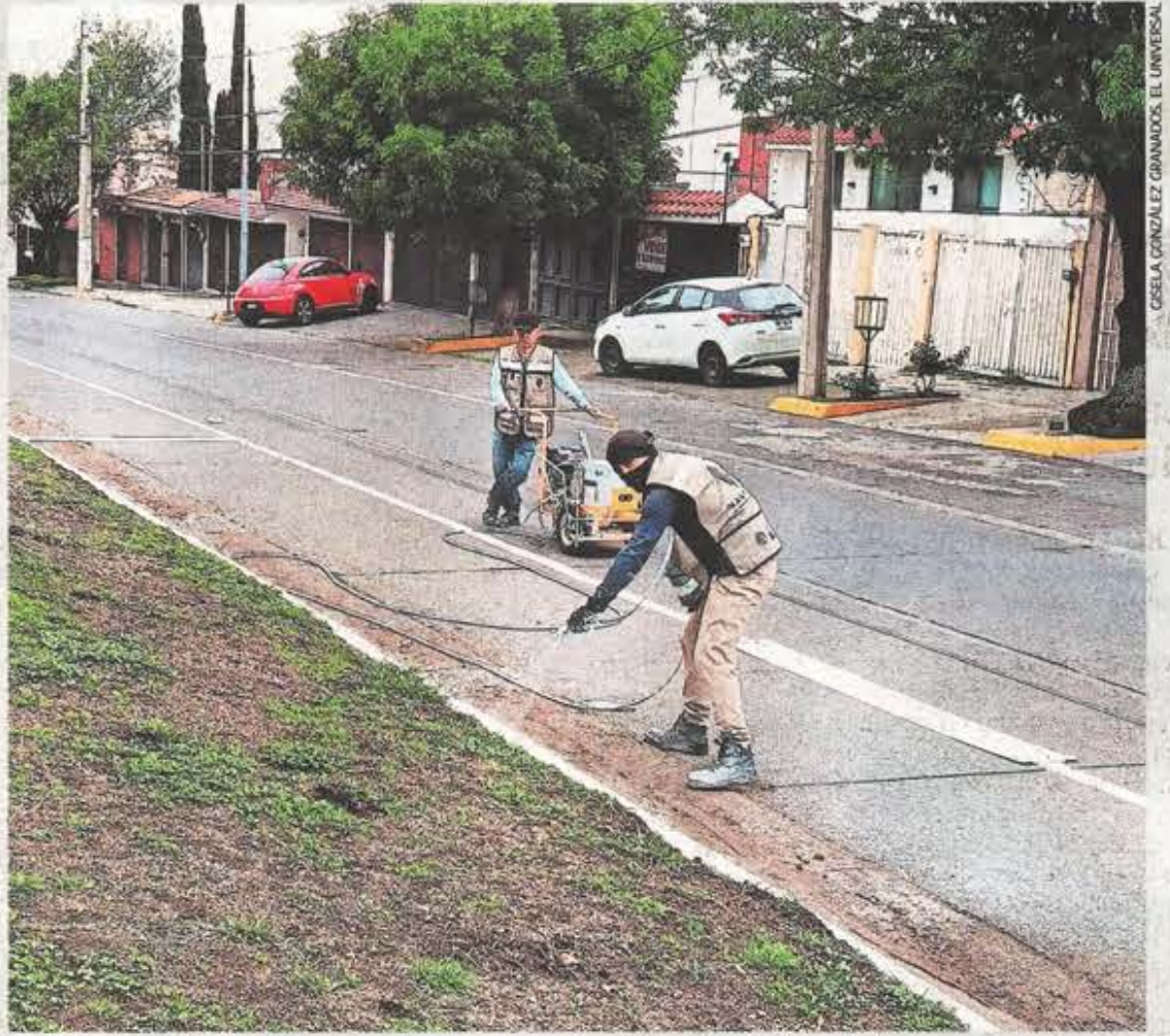
En la Zona Azul de Naucalpan comenzaron a marcar los cajones de estacionamiento.
