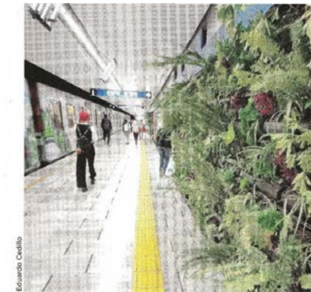
■ En Revolución, los muros en dirección Cuatro Caminos ya cuentan con la nueva infraestructura.
