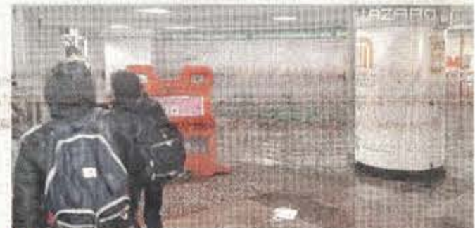
Uno de los accesos de San Lázaro quedó encharcado, dejando sin servicio a la taquilla.
