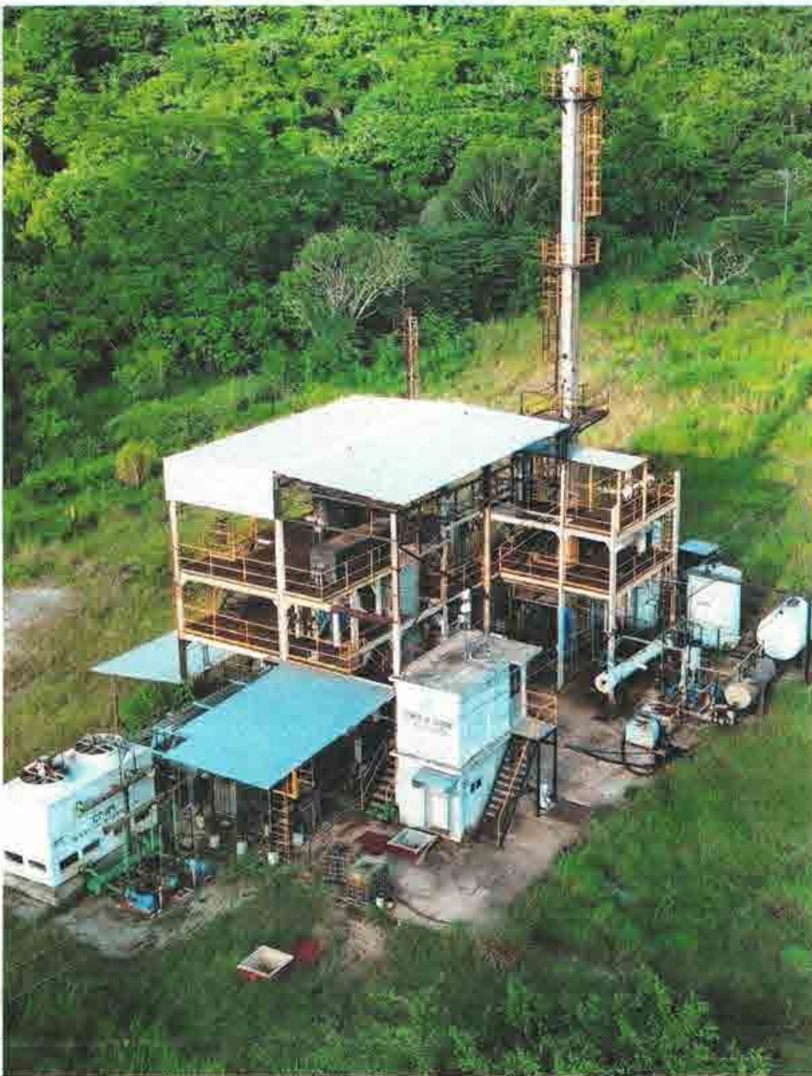
La minirrefinería asegurada en 2025 en Coatzacoalcos actualmente se ve abandonada y sin ser desmantelada.
