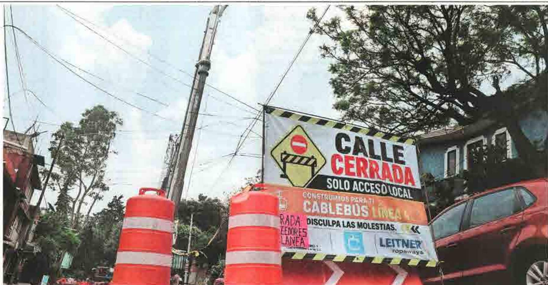
Ya concluyeron los estudios técnicos y el desarrollo del proyecto ejecutivo de la Línea 4, por lo que las empresas están con la construcción de las estaciones, dijo titular de la Sobse.
