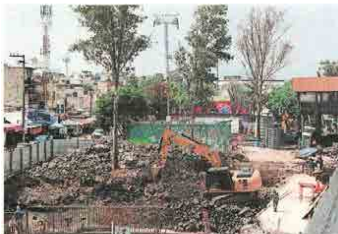
En el Cetram Universidad iniciaron los trabajos preliminares para la terminal.
