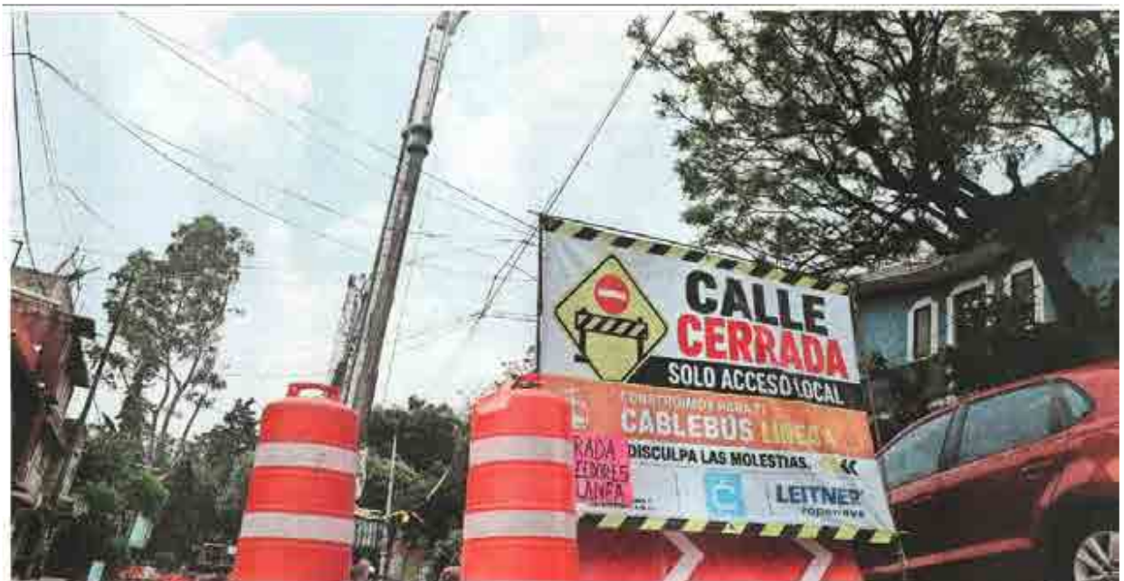
Ya concluyeron los estudios técnicos y el desarrollo del proyecto ejecutivo de la Línea 4, por lo que las empresas están con la construcción de las estaciones, dijo drular de la Sotse.
