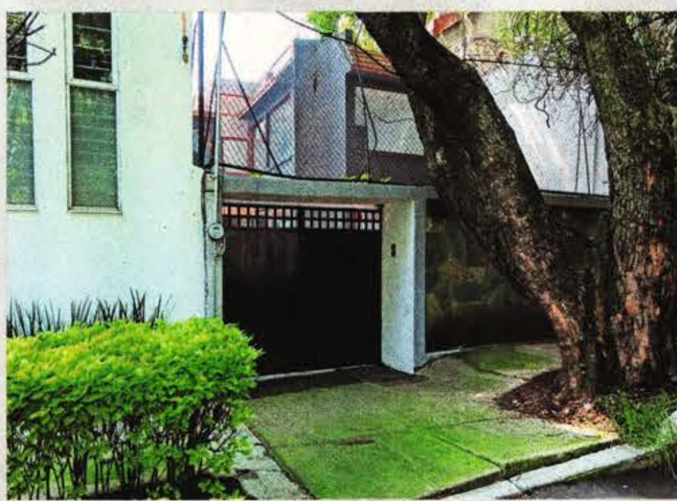
Los despojadores realizan cambios importantes en los inmuebles, denuncian víctimas.
