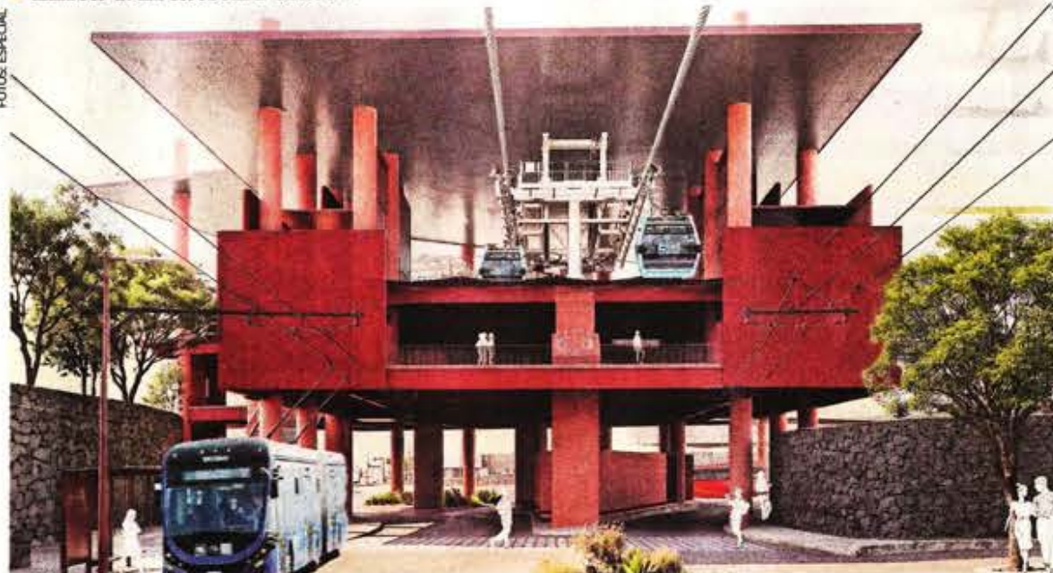
La Línea 4, que irá del Cetram Universidad a Tlalpan, se tiene previsto concluirla a finales de 2027.
