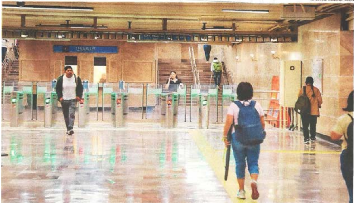
Puertas automáticas instaladas en la estación Hidalgo
