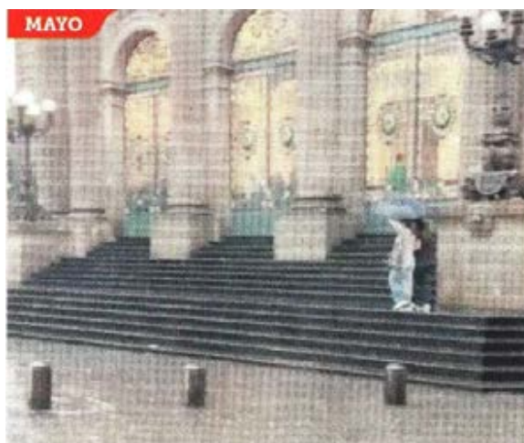
■ Calles aledañas al Congreso de la Ciudad quedaron anegadas debido a las precipitaciones.
