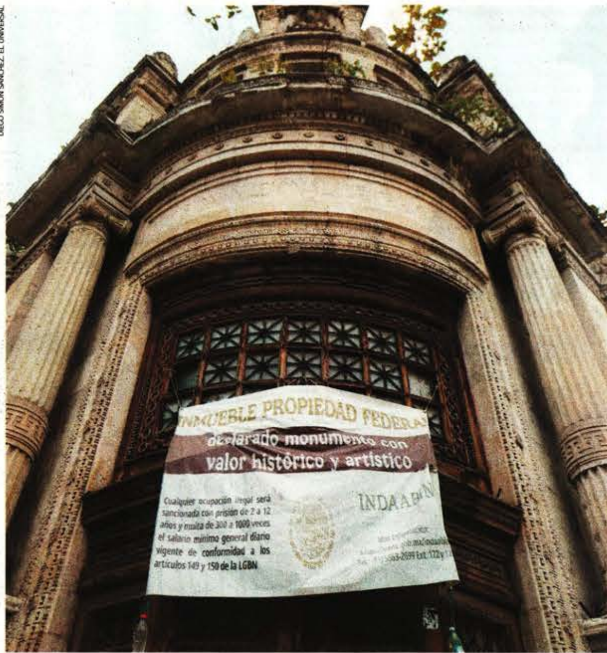
El edificio del Archivo Histórico y Biblioteca del Agua se ubica en la esquina de Balderas y Ayuntamiento.
