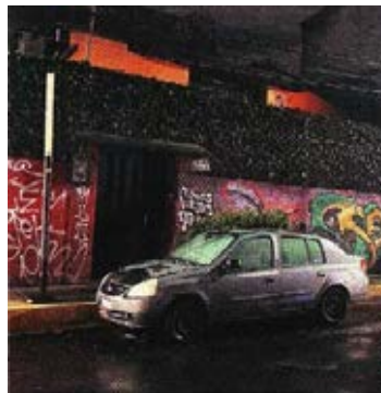
LUMINARIA inservible en una calle.
