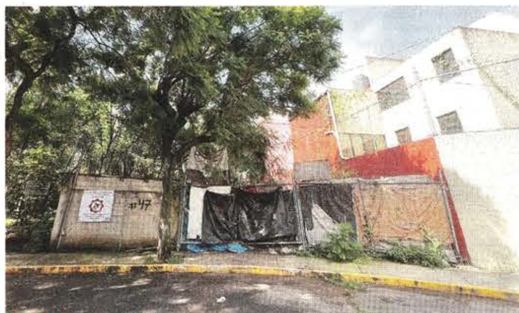
EN OBRA. El predio fue bardeado y luce en rejas lonas que impiden mirar al interior.
