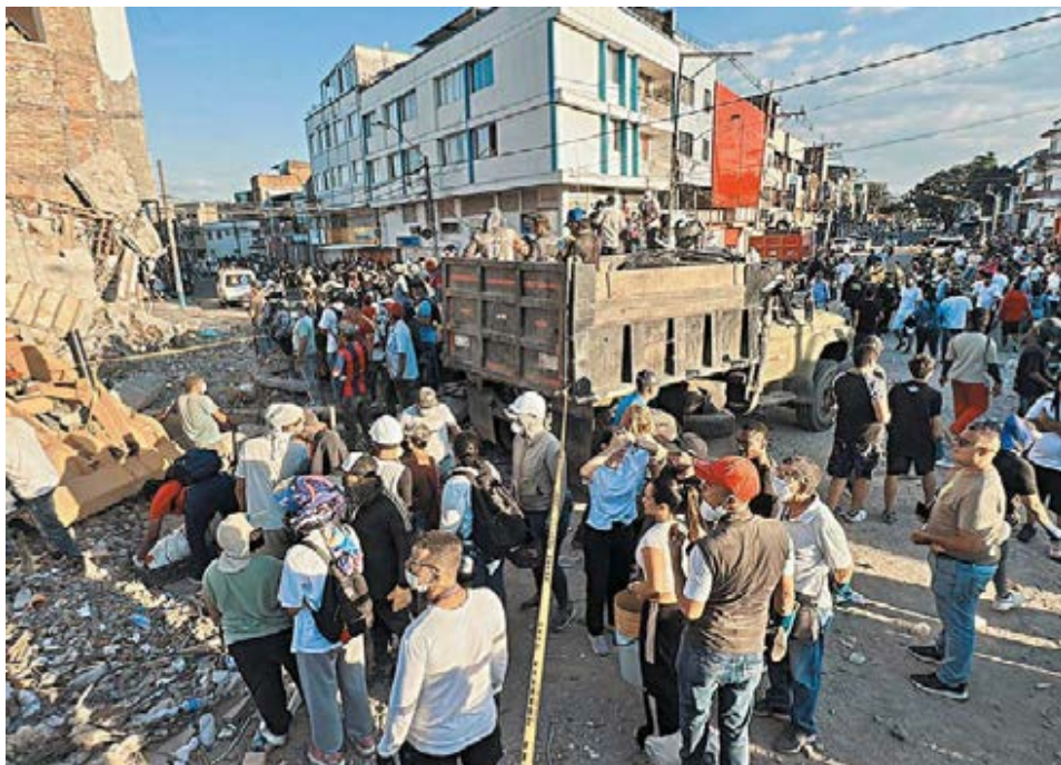
Residentes y personal de emergencia en Cali buscan sobrevivientes en un edificio colapsado. REUTERS
