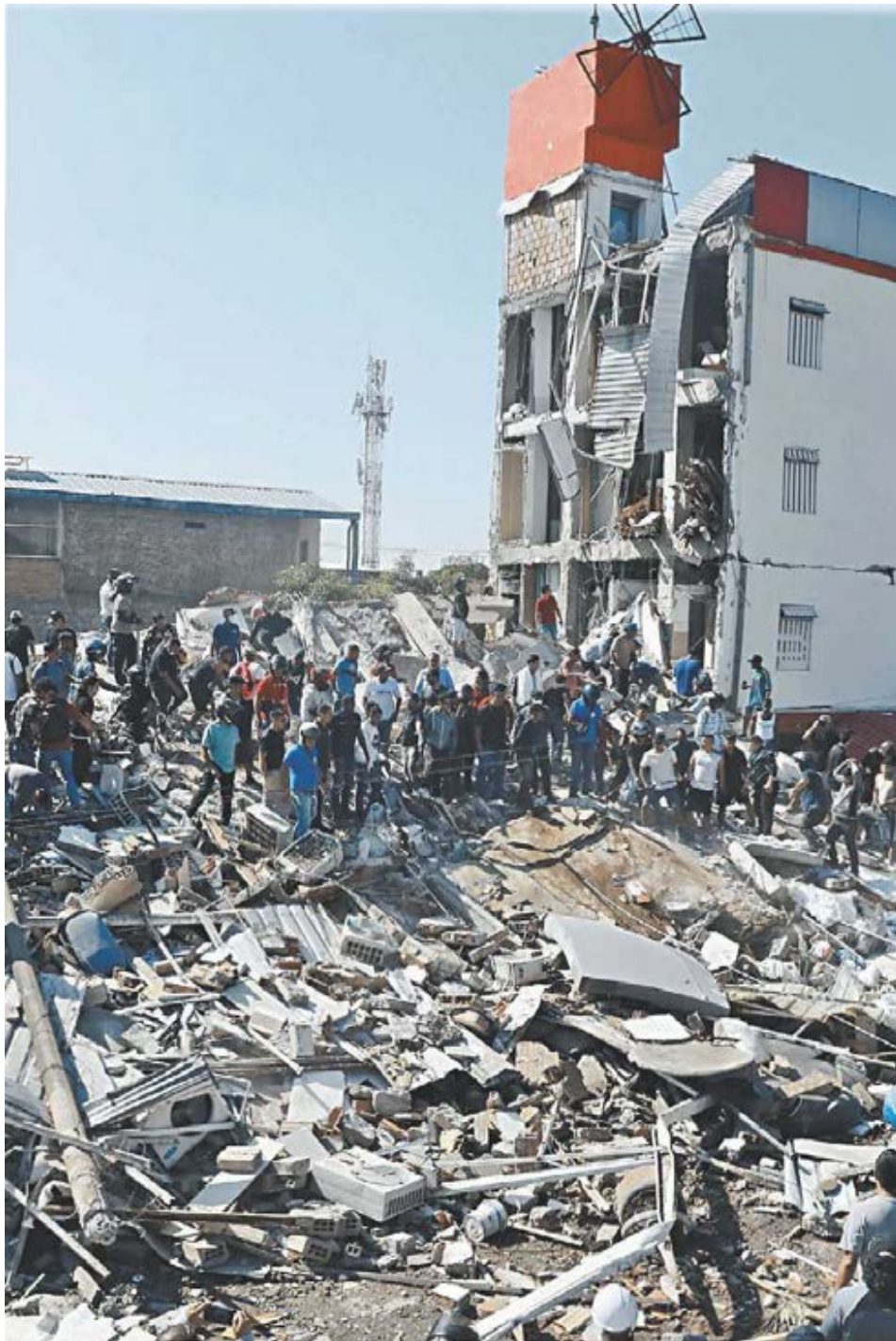
Trabajos de rescate en uno de los múltiples edificios que colapsaron en Cali. ERNESTOGUZMÁN/EFE
