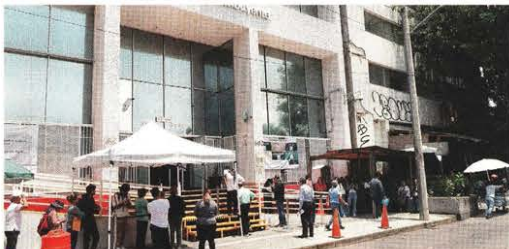
Usuarios del SAT deben esperar su turno debajo de un andamio frente al edificio con riesgo.
