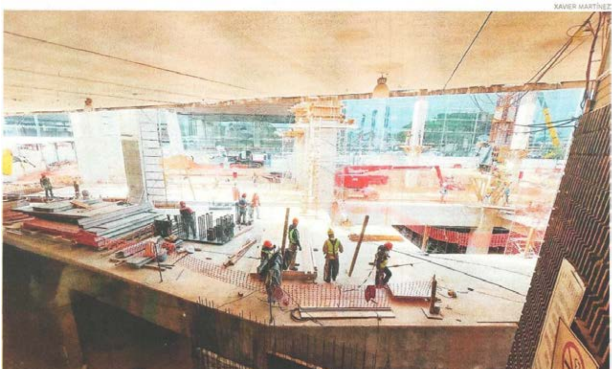
Obras en el Centro de Transferencia Modal (CETRAM) Observatorio en Sur 122 esquina Poniente 85, en la alcaldía Álvaro Obregón
