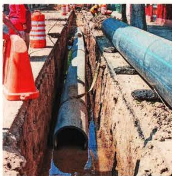
Algunas de las obras, como líneas de presión y colectores, siguen en proceso, informaron.
