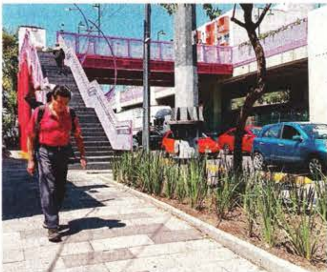
Peatones que suben al segundo piso deben sortear escaleras alejadas entre sí y falta de elevadores.
