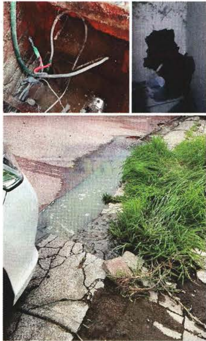
La acumulación de aguas negras en Calle Havre ha sido reportada desde hace un año por vecinos de Villa Verdún.
