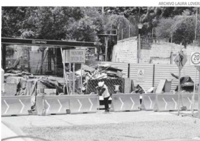
Obras de la Línea 5 del Cablebús que se realizan en la zona de Mixcoac
