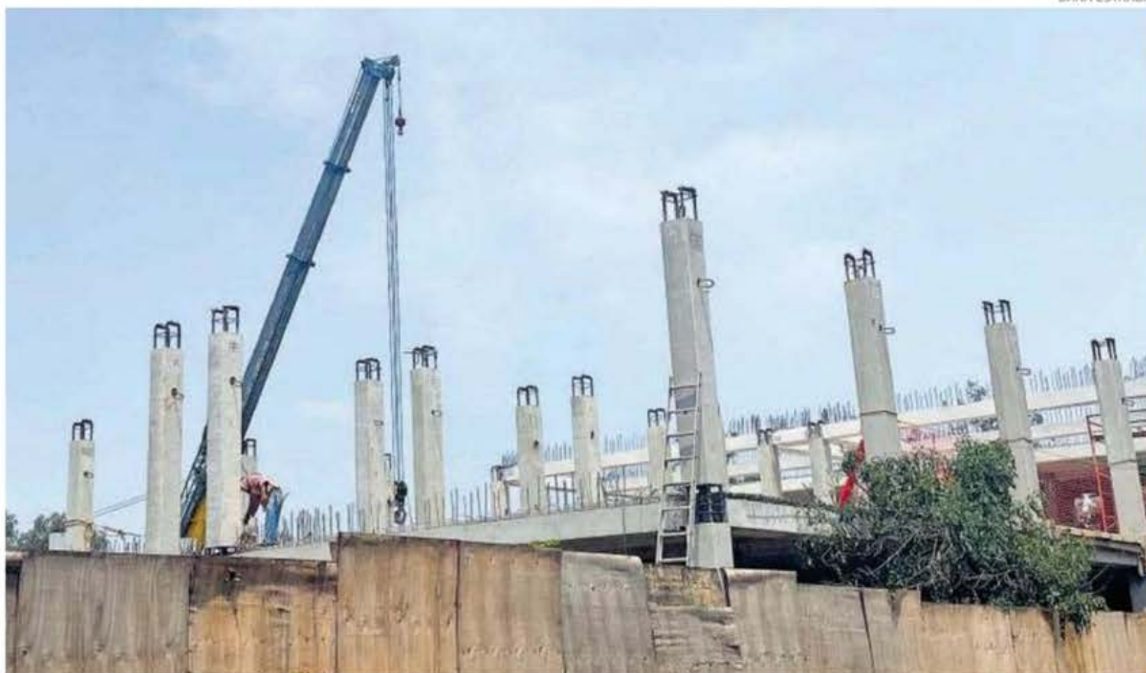
Trabajos de construcción del Centro de Resguardo Temporal para Tratamiento Forense que esperan terminar en diciembre
