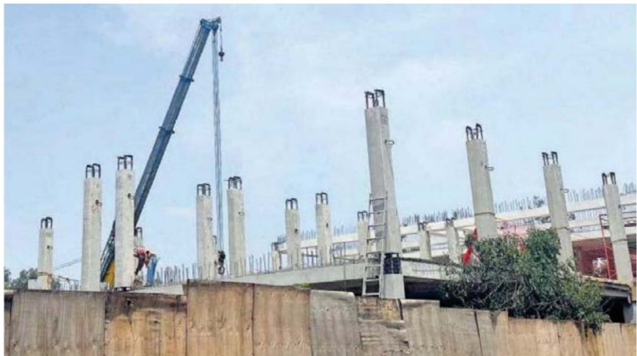
Trabajos de construcción del Centro de Resguardo Temporal para Tratamiento Forense que esperan terminar en diciembre
